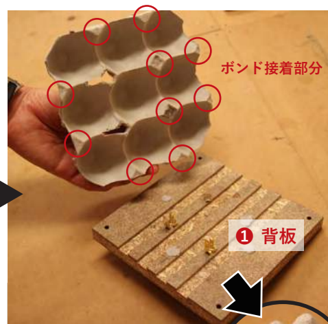
5 吸音壁の接着部分にボンドを塗り、 1 背板の裏側に接着する。
