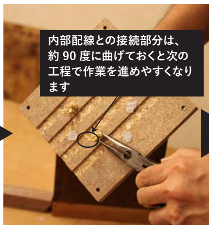
19 ターミナル端子の裏側のナット部分を、動かないようにプライヤーなどでしっかりと固定する
