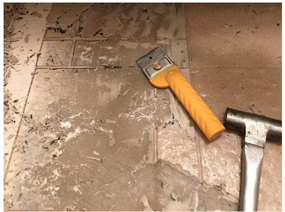
施工中(下地調整)
