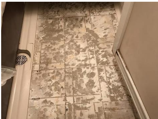
施工中(下地調整)
