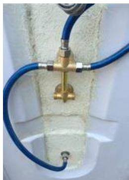
給水給湯金具の増締め
